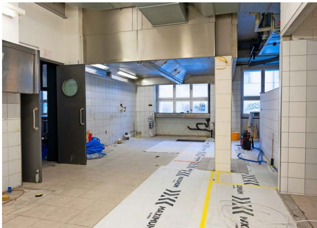
Die Küche wird neu eingerichtet. Rechts soll eine Ecke entstehen, in der man geschützt arbeiten kann.
